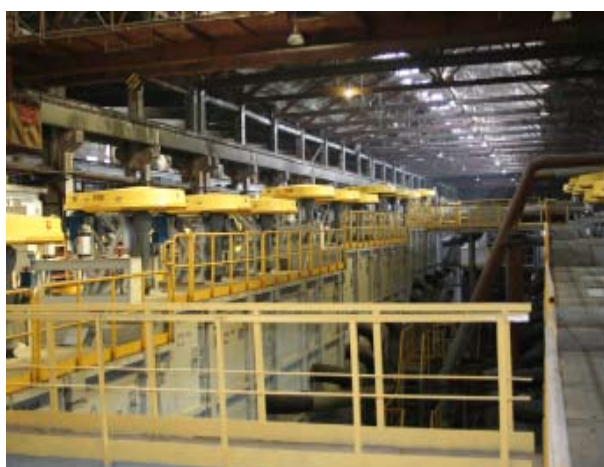
Реконструкция флотационного отделения медной обогатительной фабрики ОАО «Алмалыкский ГМК», УЗБЕКИСТАН
