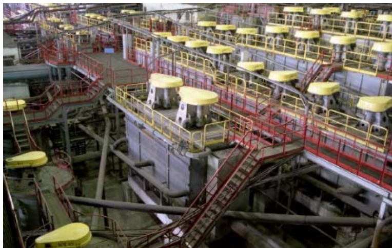
Реконструкция обогатительной фабрики на Учалинском ГОКе, РОССИЯ
